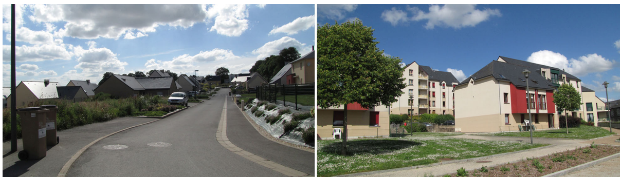
Quartier de La Martinais à Lécousse et opération des Urbanistes à Fougères
